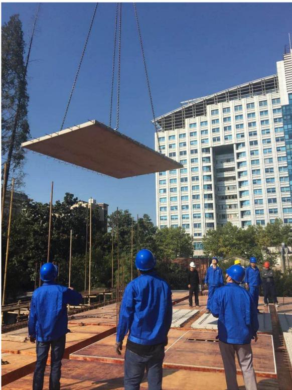
本报讯 10月11日上午7时,杭州第二中学东河校区求是楼1区建筑装配式PC构件正式开始吊装。
