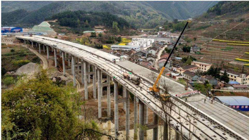
于项目位于山区，施工沿线地形复杂，岩层多变，地质灾害隐患较多，桥墩下部基础成型难，7座桥中还有4座是在水库库区。”李宝地举例说，比如第3座桥罗镇泾河大桥，一根桩基就打了一个多月，桩基深度达28米。
