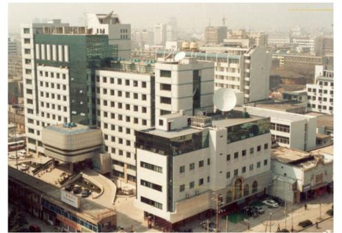
在各方人员的共同努力下，1996年9月，浙江省财政厅综合办公楼如期建成。此工程为框架剪力墙结构，地下两层，地上11层，建筑高度44米，面积共20179平方米。
